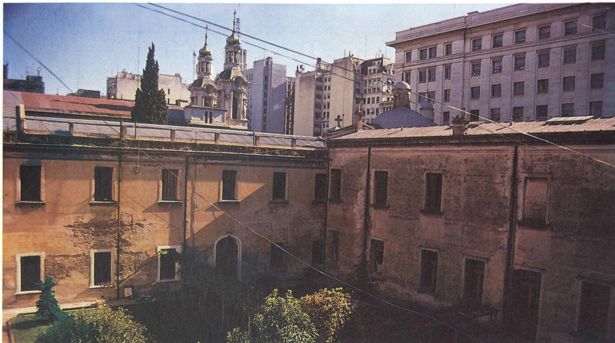
7. Vista actual del claustro franciscano desde la cubierta de los conventillos.
