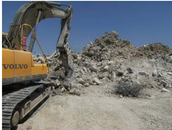
Figura 8. Retroexcavadora de cadenas con pinza hidráulica.
