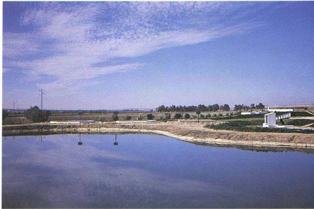
El sistema de lagunaje implantado en la Planta Experimental, recurre al empleo de tres tipos de procesos biológicos operando en serie. En concreto, se dispone de dos lagunas anaerobias, una laguna facultativa y dos lagunas aerobias de maduración.
