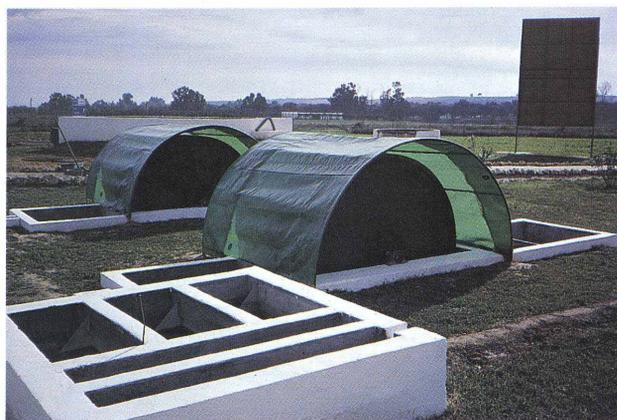
La Planta Experimental cuenta con diferentes sistemas de Contactores Biológicos Rotativos: **Biodisco**, **Biocilindro** y **Biorrotor Aireado**.
