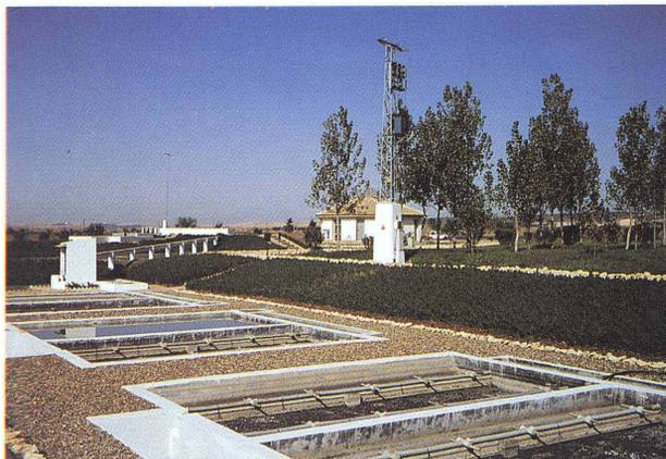
El sistema de Filtros de Turba consta en su conjunto de: tamiz estático autolimpiable, desengrasador y seis unidades de filtración de 25 m<sup>2</sup> cada una (agrupadas en tres módulos de dos).
